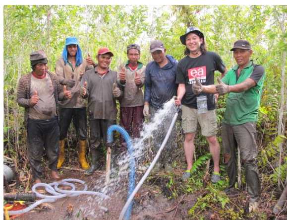
掘り抜き井戸掘削の現場を見る
